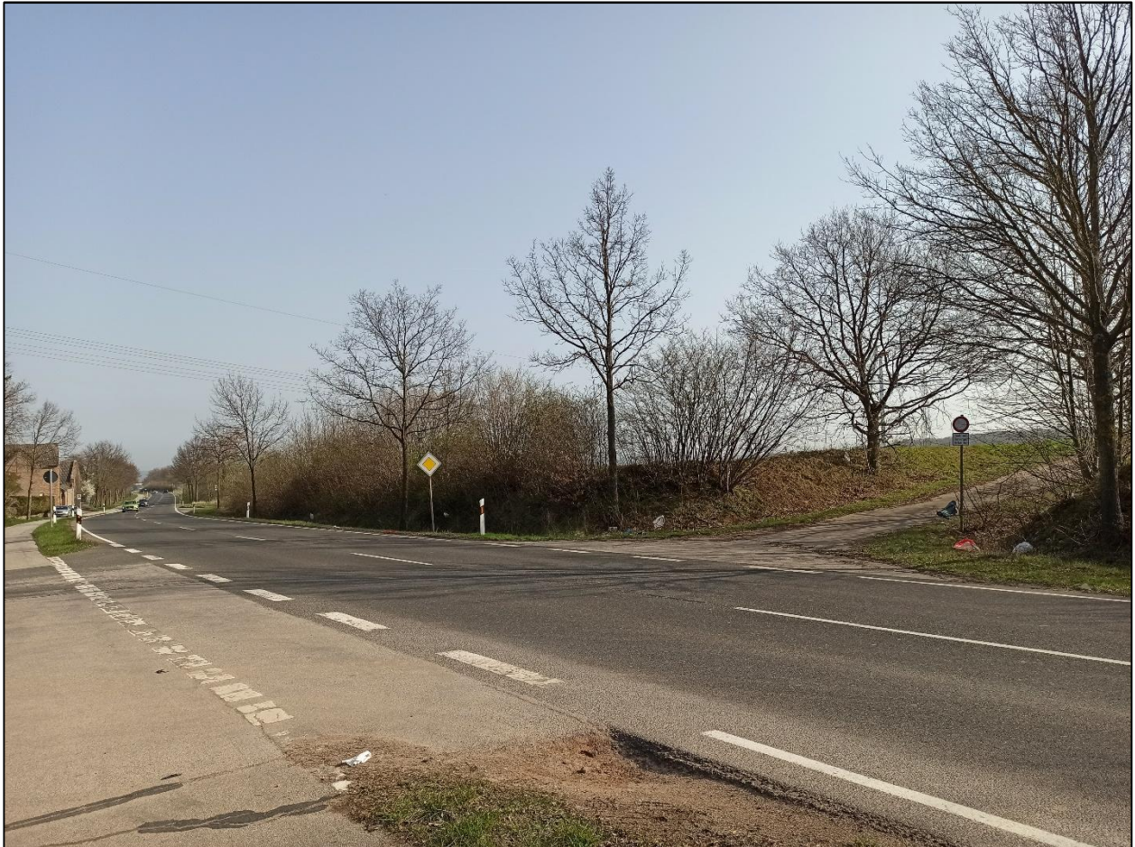
Abbildung 5: Knotenpunkt L 249 / Zuwegung Wirtschaftsweg – Blickrichtung Norden
