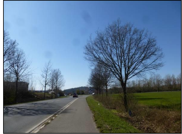
Abbildung 11: Landesstraße L 33 mit Gehölzbestand und Graben.
