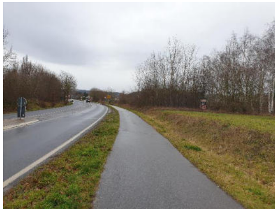
Foto 2: Jülicher Straße in Blickrichtung Osten zum Kernort Nideggen, Planstandort rechts
