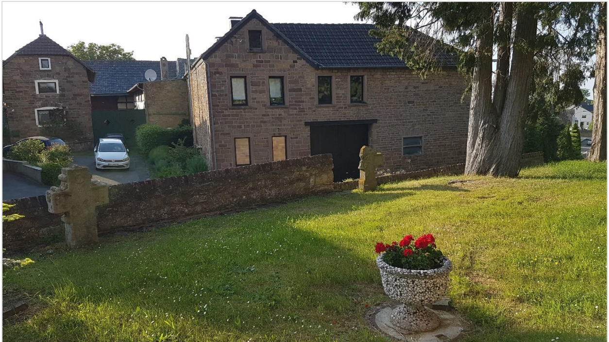
Abb. 5: Niedrige Mauer an der Kirche Foto: Planungsgruppe MWM 2021
