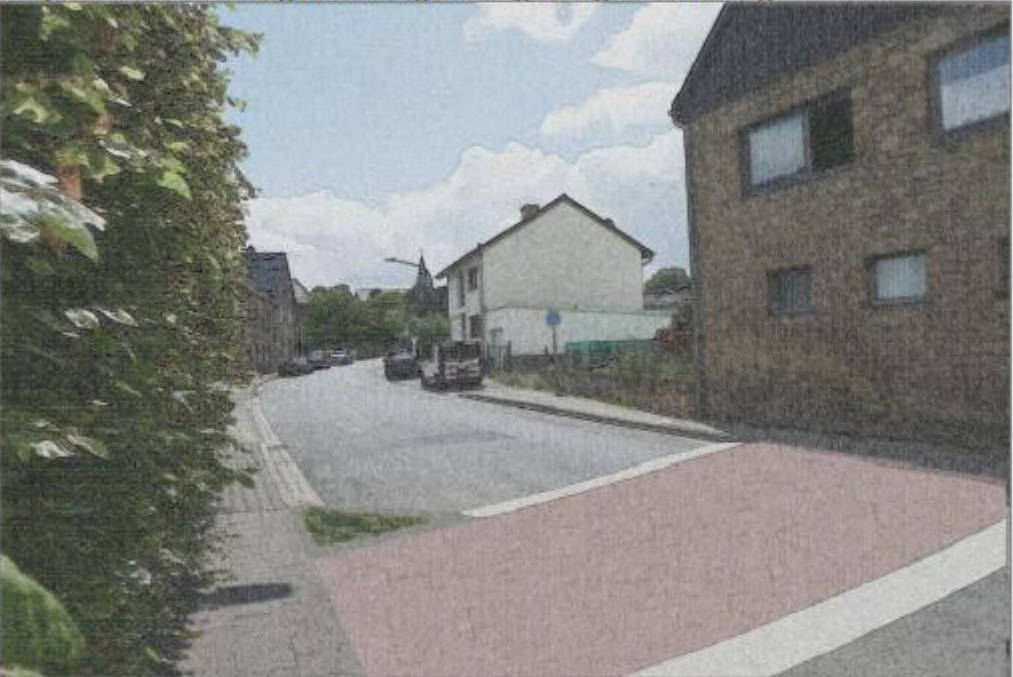
Beispiel für die Aufweitung der Gehwege mit Begrünung und Erhöhung.
